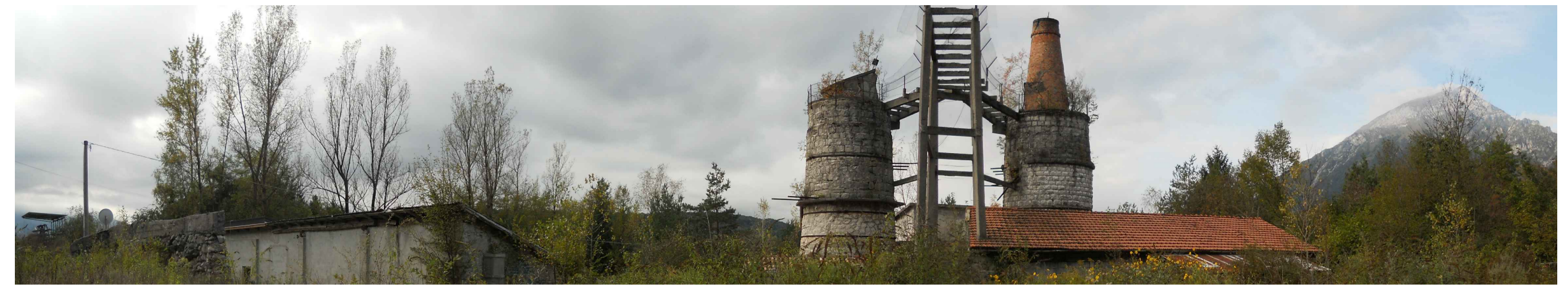
PANORAMICA DEL COMPLESSO EX FORNACE CALCEBIANCA - VISTA IN DIREZIONE OVEST
